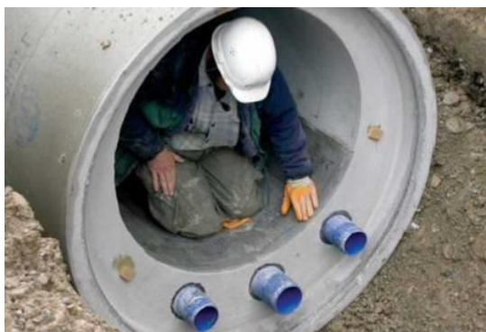
Figure 78 : Canalisation préfabriquée avec échangeur de chaleur intégré (Guide pour les maîtres d'ouvrages et les communes, OFEN)
