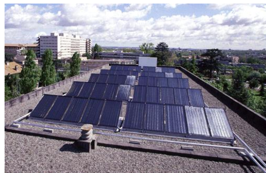
Capteurs solaires destinés à la production d'eau chaude sanitaire pour un hôtel
