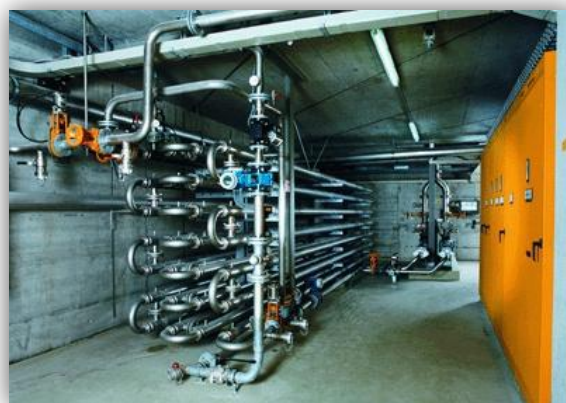
Figure 84: Echangeur tubulaire en sortie de STEP (Lyonnaise des Eaux, ISTINOX, ANTEA)
